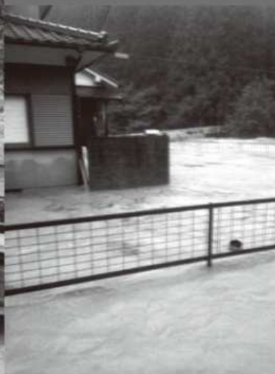
◀ 河川と化した長谷の国道309号（午前6時20分現在）
