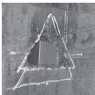
▲コンクリートに開けた穴
